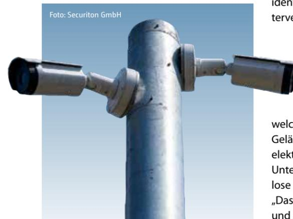
Thermalkameras überwachen die Umspannanlagen. Sie eignen sich besonders gut, um Täuschungsalarme durch Störgrößen, wie Regen oder Nebel, zu minimieren.
