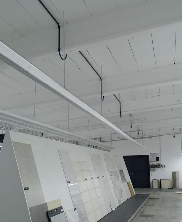
horizontal sowie vertikal angebracht werden können und zum anderen die Auswerteeinheiten bei Bränden bereits kleinste Rauchpartikel erkennen. Dies garantiert eine frühestmögliche Branddetektion – noch bevor größere Schäden entstehen.
