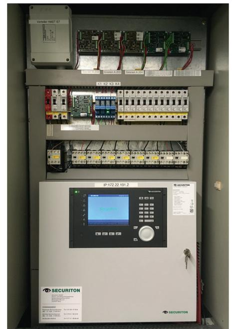
Eine der fünf Brandmeldezentralen SecuriFire 2000 im Einsatz bei der H-Bahn.
