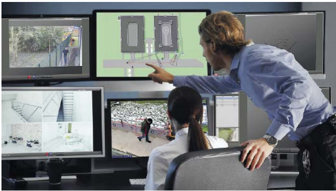
Der IPS VideoManager sorgt insgesamt für kürzeste Reaktionszeiten zur Einleitung von Interventionsmaßnahmen bereits während der Gefahrenentstehung
