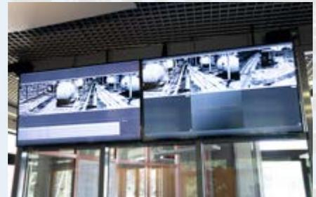
Bedienpersonal jederzeit Zugriff auf jede einzelne Kamera und kann sehr einfach alle 27 Standorte mittels eines Einzelarbeitsplatzes verwalten. Der Datenverkehr zwischen den Standorten und der Zentrale ist minimal. Größere Datenmengen entstehen nur bei einem Alarm und einem manuellen Zugriff. Sollte es zu einem Ausfall kommen, ist das System mit einer unterbrechungsfreien Stromversorgung ausgerüstet und kann sich sogar selbstständig wieder starten.
