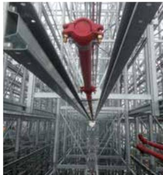
eingebauten Leitungsnetz: Neun davon sind Nassalarmventile, eine davon eine Preaction-Ventilstation, also eine vorgesteuerte Sprinkleranlage, die erst Wasser freigibt, wenn ein automatischer Brandmelder Alarm auslöst. Zwei Sprinklerpumpen (132 kW) befördern das Wasser aus einem Sprinklerreservoir mit über 150 m<sup>3</sup> Kapazität.
