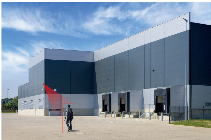
Intelligente Videoüberwachung erkennt Eindringlinge zuverlässig und verfolgt diese automatisch auf dem Areal sogar über mehrere Kameras hinweg. Foto: Securiton Deutschland
